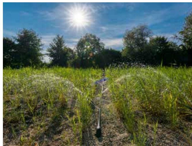
Das abgebadete Beckenwasser wird über den Geomatrix®-Bodenfilter aufbereitet.
